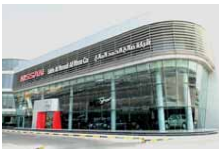
Nissan Showroom, Doha oben: herkömmliches Glas unten: AMIRAN®
