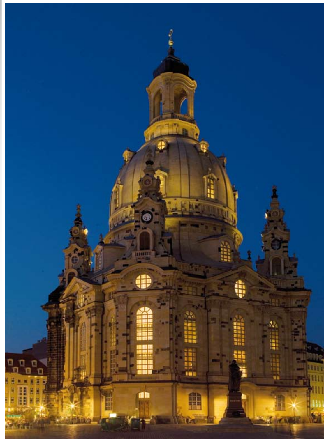
Frauenkirche Dresden, Verglasung mit Restaurationsglas
